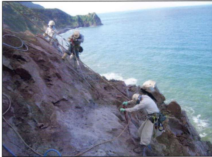
☆一般国道231号線増毛町赤岩改良工事☆ (ロックスパイダー〈高所法面作業車〉・人力破碎他)
