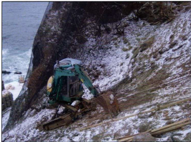
☆一般国道231号線増毛町赤岩改良工事☆ (ロックスパイダー〈高所法面作業車〉・人力破碎他)
