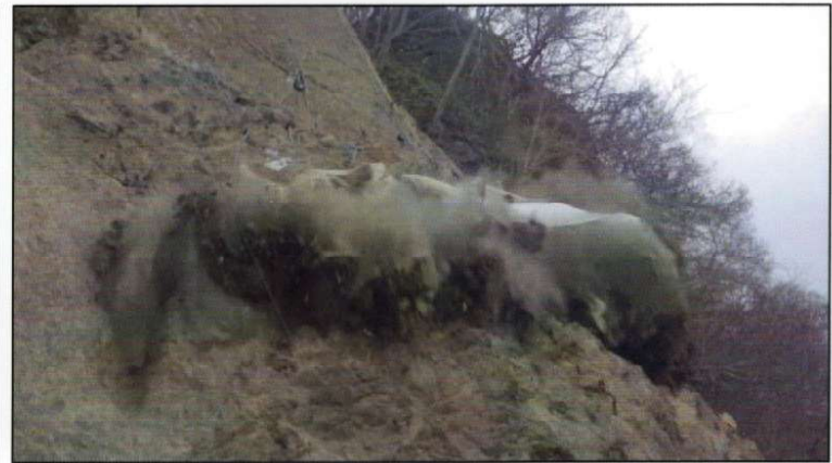
☆一般国道336号ピタタヌンケ法面防災工事☆ （非火薬工法に拠る法面岩盤破碎）
