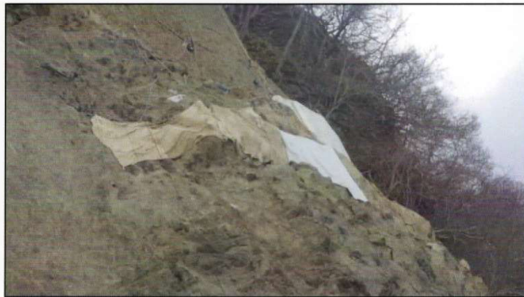
☆一般国道336号ピタタヌンケ法面防災工事☆ （非火薬工法に拠る法面岩盤破碎）
