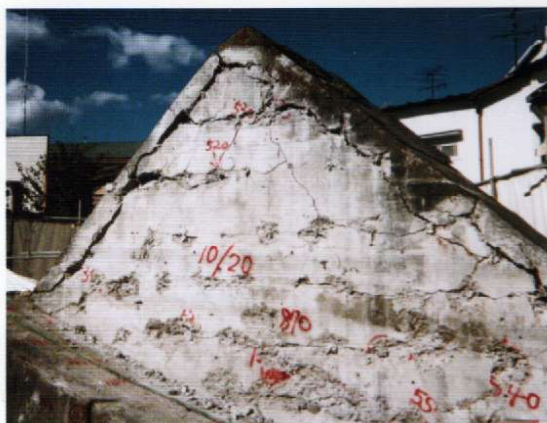
基礎コンクリートの破碎
