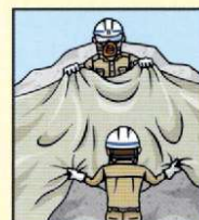
防護シートで養生
